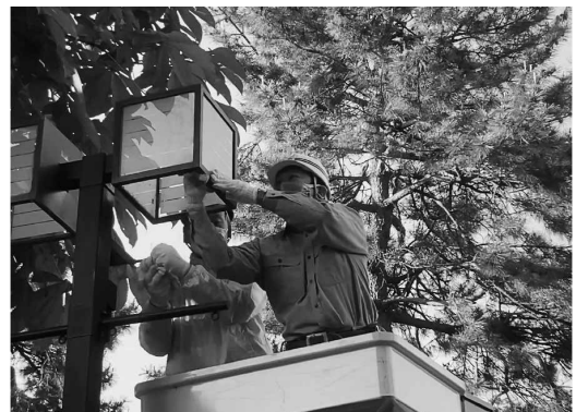
高所作業車での作業
