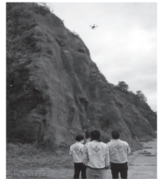
ドローンを飛ばしてのり面の表面温度を調べる(日本経済新聞 Web 版より)
