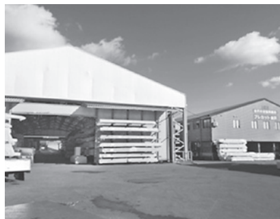
組合外観および木材保管倉庫
